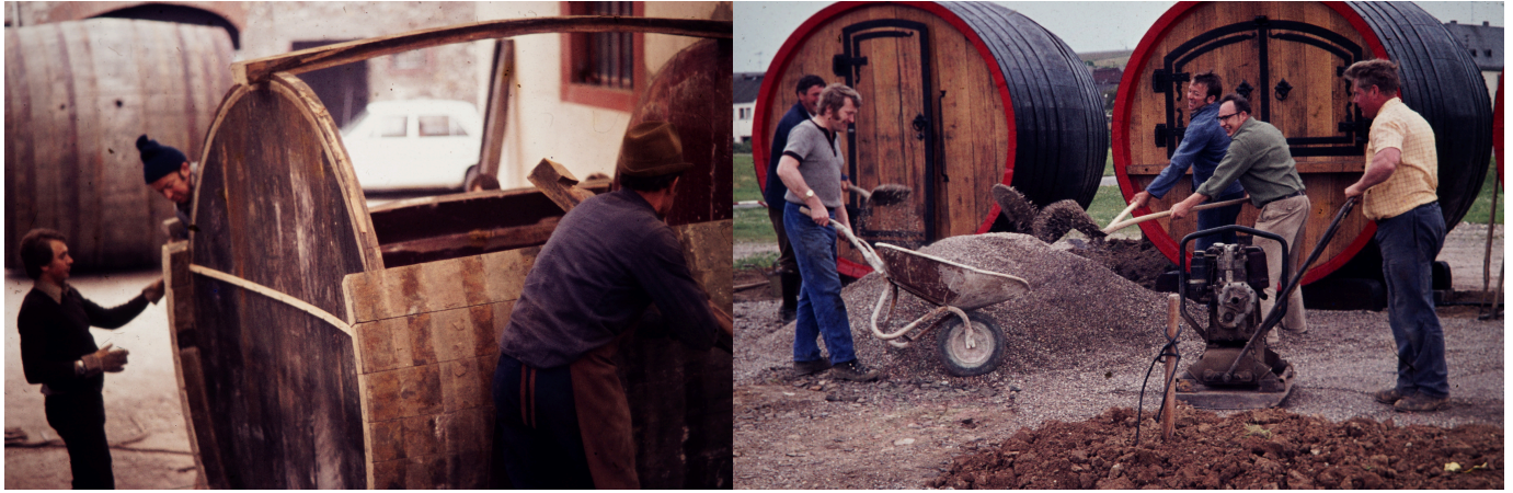
Bau des Hattenheimer Weinprobiertand
